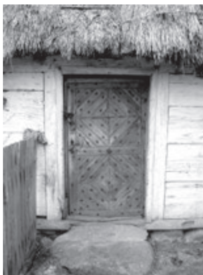
Il. 12. Opuszczona, zrujnowana i dziś nieistniejąca chałupa drewniana z Grądów Dolnych – części Pyzdrskich Olędrow, o konstrukcji sumikowo-łątkowej, jednorakto- wa, kryta słomą, zbudowana w okresie międzywojnia, od strony ulicy.
