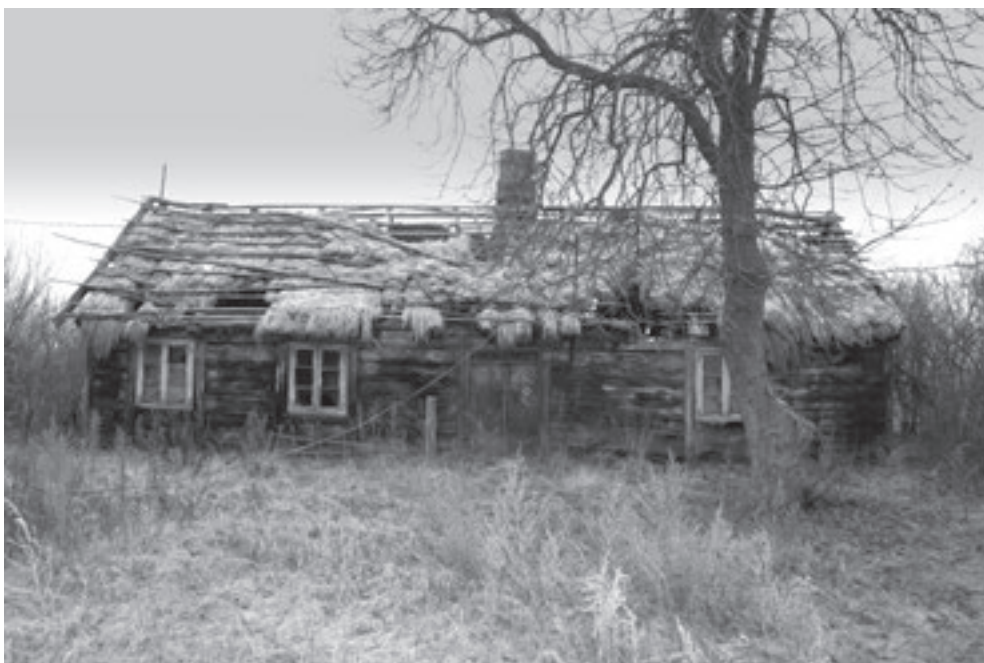
Il. 12. Opuszczona, zrujnowana i dziś nieistniejąca chałupa drewniana z Grądów Dolnych – części Pyzdrskich Olędrow, o konstrukcji sumikowo-łątkowej, jednorakto- wa, kryta słomą, zbudowana w okresie międzywojnia, od strony ulicy.
